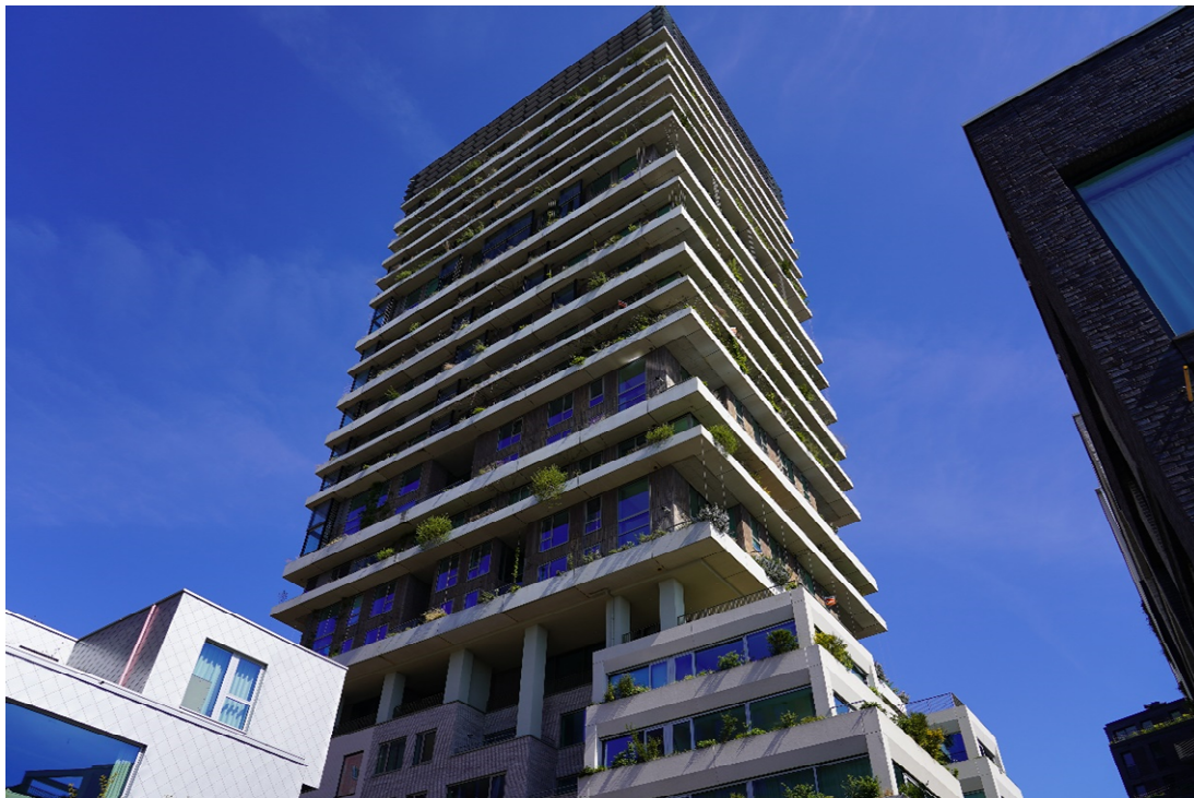
Figuur 3.1 - Bouwproject Vertical in Sloterdijk Stationskwartier
